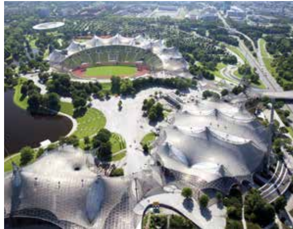
1 Das Olympia-Gelände in München mit seiner charakteristischen Dachkonstruktion nach Plänen von Günter Behnisch und Frei Otto. Foto: Architekturbildarchiv, Thomas Robbin
