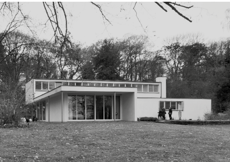
Die Eingangsseite des Haus Heusgen, die zum Garten ausgerichtet ist. Foto: Daniel Lohmann.
