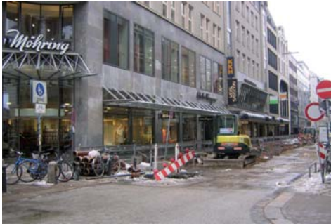
↓ Umgestaltung des Neuen Walls in Hamburg im Rahmen des BID
