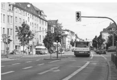
Die Herner Straße nach dem Umbau (Quelle: Stadt Bochum)
