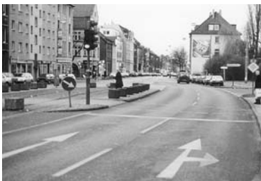
Die Herner Straße vor dem Umbau (Quelle: Stadt Bochum)
